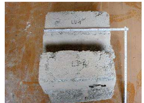
Entnahme großformatiger Betonsteine
