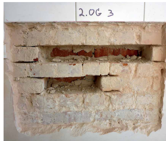
Abb. 13: Entnahme der Mauerwerksproben Ziegelstein und Mörtel
