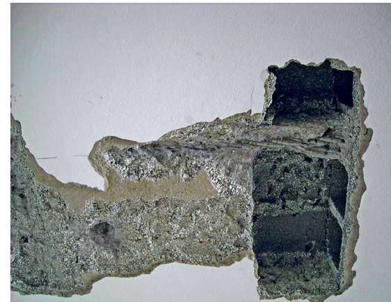
Abb. 4: Kalibrierungsöffnung zu dem in Abb. 3 dargestellten Radargramm
