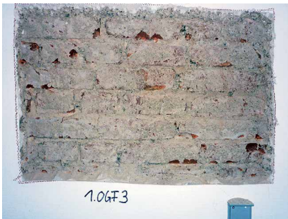
Abb. 15: Mauerwerksfenster zur Überprüfung des Mauerverbandes und der Abmessungen der Mauersteine
